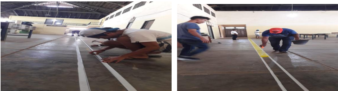
Gambar 3. Gambar menentukan dan mengecat line work mesin.
