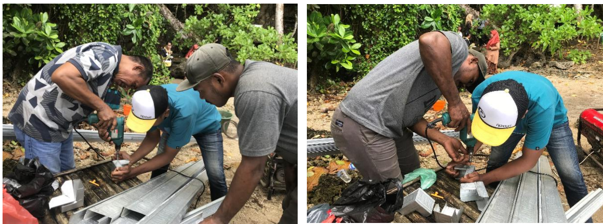
Gambar 3. Pelatihan Pembuatan Rangka Atap Baja Ringan
