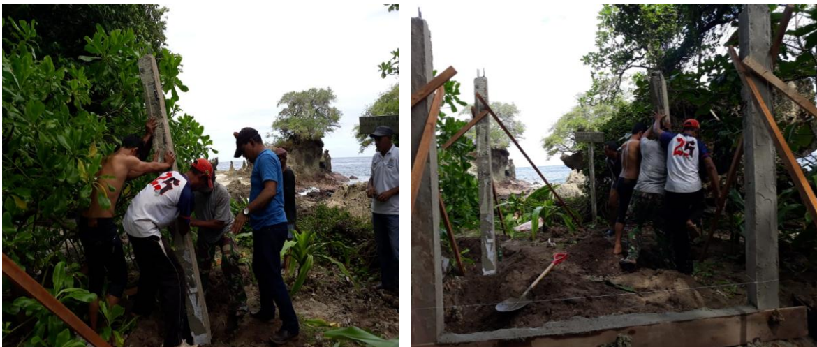
Gambar 1. Kegiatan Pengecoran Tiang Gazebo di Pantai Huluwa
