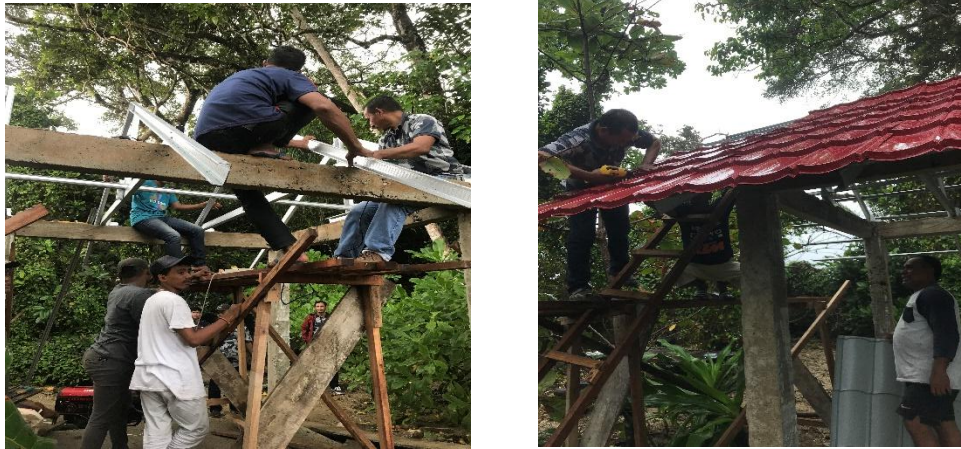
Gambar 4. Pemasangan Genteng Gazebo
