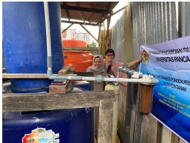
**Gambar 5. Filter yang digunakan untuk media penyaringan**
