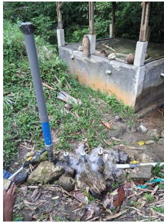
Gambar 1. Pompa Hidram (Sumber: Dokumentasi Penelitian)
