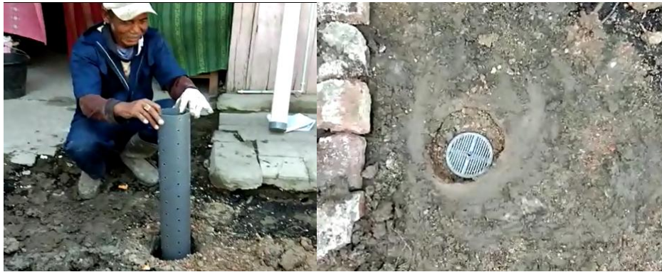
Gambar 10. Pemasangan LRB di halaman rumah warga ke III
