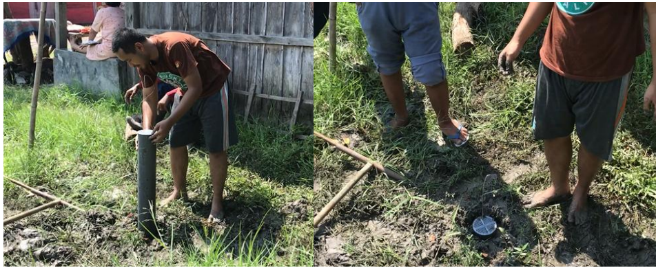
Gambar 7. Pemasangan LRB di halaman rumah warga ke II
