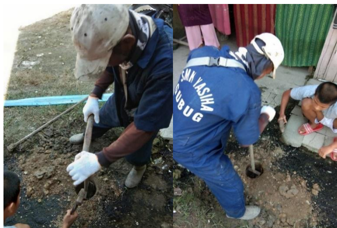
Gambar 9. Penggalian tanah untuk LRB di halaman rumah warga ke III
