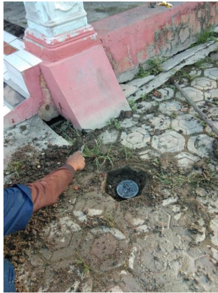
Gambar 13. Pemasangan LRB di halaman rumah warga ke IV
