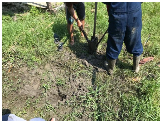
Gambar 6. Penggalan tanah untuk LRB di halaman rumah warga ke II
