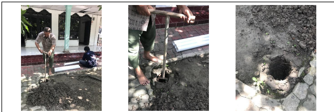
Gambar 3. Penggalan tanah untuk LRB di halaman rumah warga ke I
