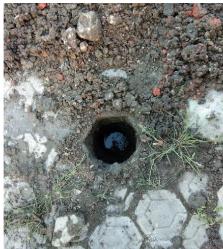
Gambar 12. Penggalan tanah untuk LRB di halaman rumah warga ke IV
