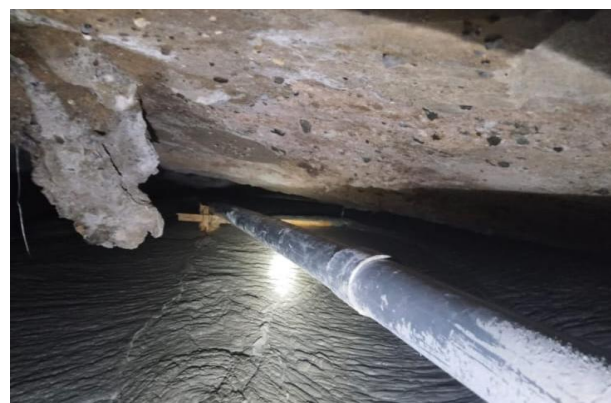
Gambar 1. Celah mendatar pada bawah oprit jembatan
