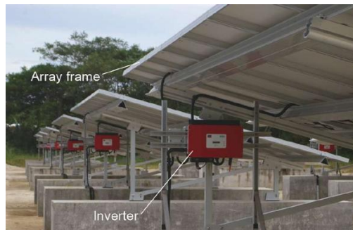
Gambar 4. Inverter dan bingkai
